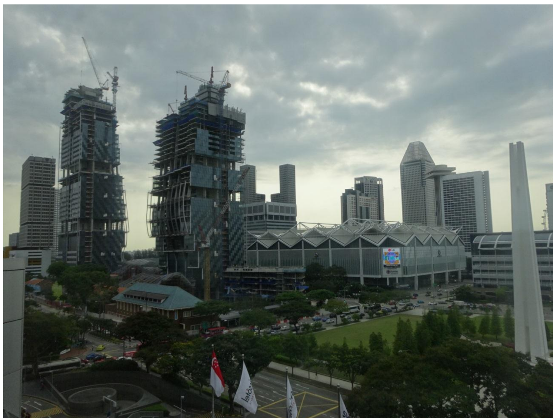
街の中心部では建設中のビルも数多い
