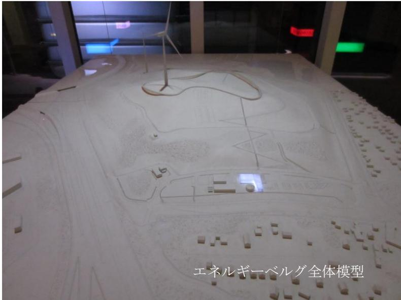
現在、有毒ガスの発生や汚染水のチェックを行う一方、メタンガスの再利用として、近くの製鋼所にパイプラインでガスを送り、工場で使用する電力を発電している他、丘の一番高いところに、羽の直径が100mの風力発電装置が設置されており、3.4Mwの能力を有することから、
